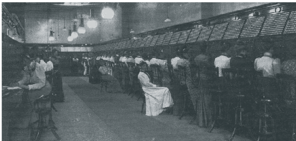
Manuelna telefonska centrala
