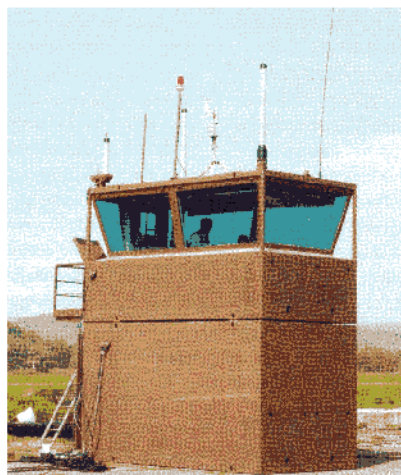
Na prateći kontejner (TNK) postavlja se taktički kontrolni toranj (TMV) i zajedno čine toranj za vazдушnu kontrolu saobraćaja
