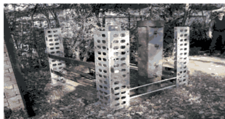
Slika 11 – Postavljanje kostura peći Figure 11 – Assembling the prefabricated body
