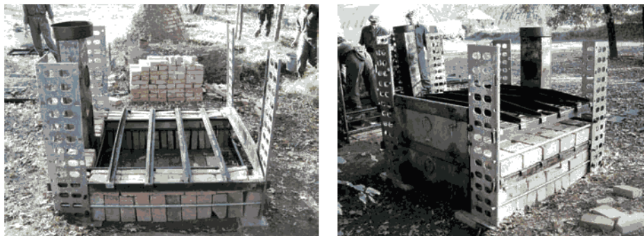
Slika 12 – Zidanje peći Figure 12 – Masonry work
